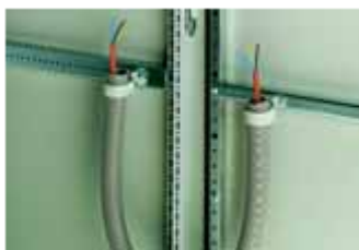
Рисунок 14.18 – Крепление кабельного гофра при помощи держателей
